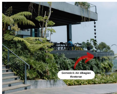
Gambar 20. Suara Gemerik Air Pada Bagian Restoran Sumber: Dokumentasi Pribadi, 2024
