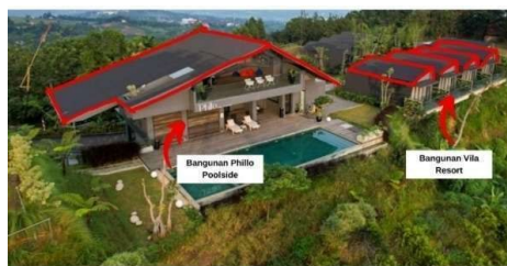
Gambar 3. Bentuk Atap Bangunan The Upper Clift Resort & Cafe Sumber: Data Pribadi, 2024
